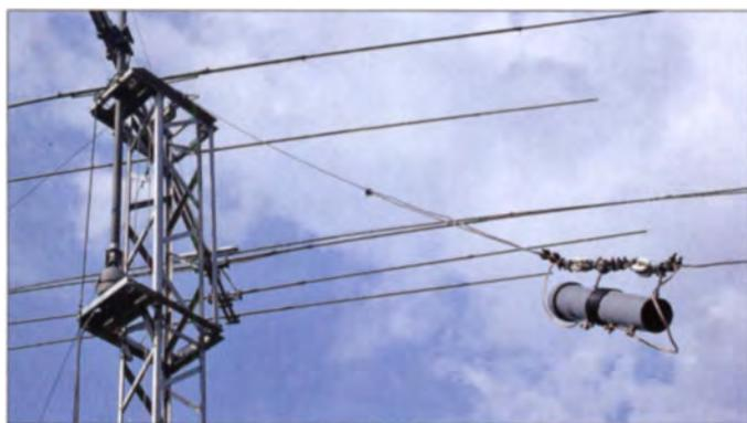
Bild 1: Ausführung des Sperrkreises am Sloper; dahinter der Mast mit KW-Beam
